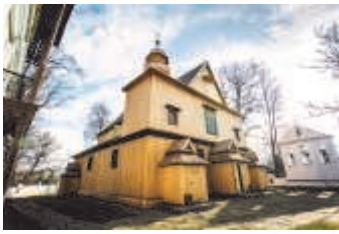
Kościół parafialny pw. św. Michała Archanioła w Szalowej
